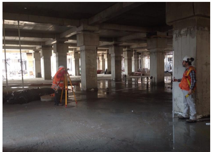
Control topográfico para toda la obra
