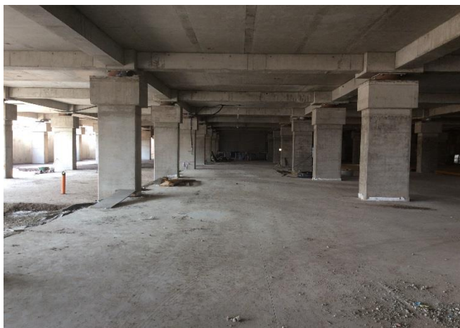
Avance de radier en edificio CDT
