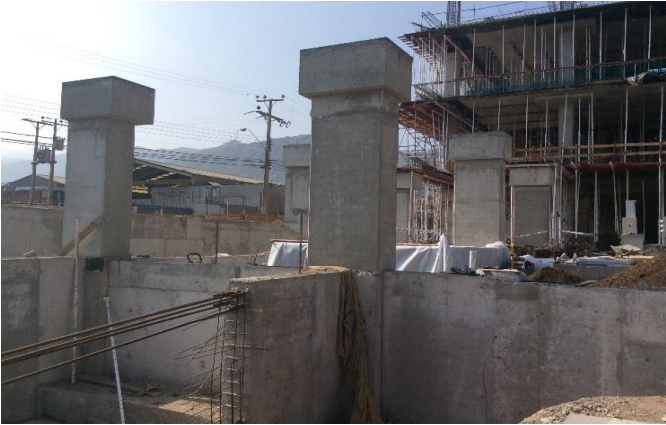
Grout en capiteles edificio CDT
