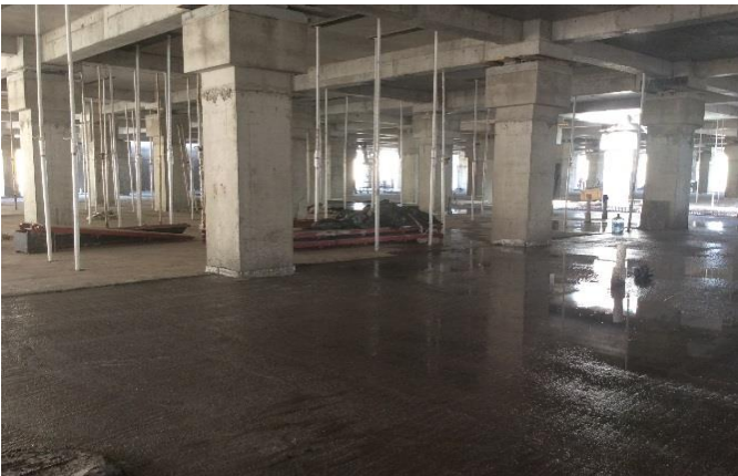
Avance Radier en edificio UPC
