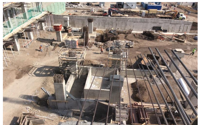
Avance en la colocación de hormigón en Centro Diagnóstico Terapéutico CDT
