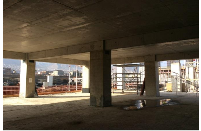
Avance en la colocación de hormigón en edificio Torre Hospitalización TH
