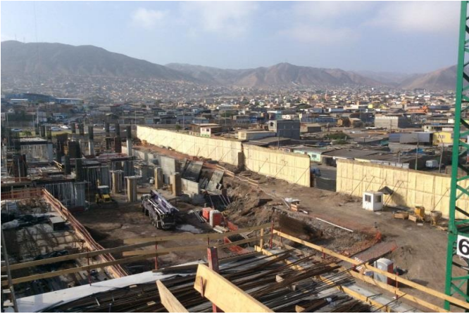
Avance enfierradura Torre Hospitalización TH
